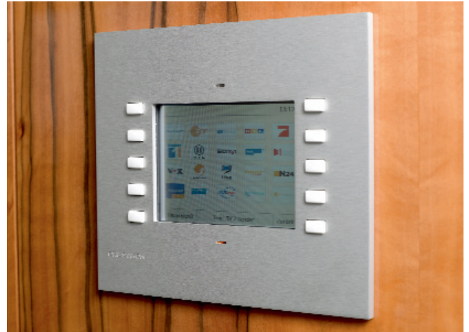
Eines der zahllosen Crestron-Panels, das den Bewohnern Kontrolle über Licht, Verschattung, Klima und den guten Ton bietet
